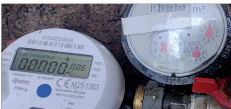
Imagen de dos contadores: el tradicional, de lectura manual y el nuevo instalado, digital.
